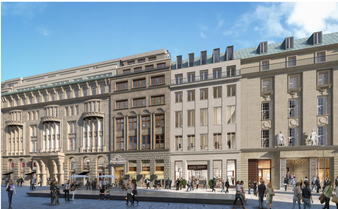
Alter Wall Hamburg: Blick auf die historische Fassade der Häuser Alter Wall 2-32 vom Adolphsplatz aus Bildquelle / Nutzungsrechte: Art-Invest Real Estate
